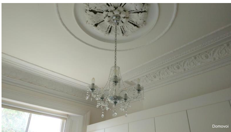
Результат работы – потолок из гипсокартона с сохраненной лепниной
